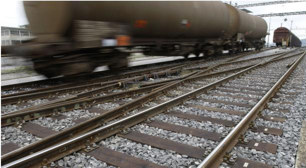
En cas de d eraillement, les traverses en bois ne se brisent pas, malgr  le poids exerc  par la roue m tallique. Moyennant les travaux d'urgence au point de d eraillement, la voie reste utilisable car l' cartement reste garanti, ce qui n'est pas le cas avec des traverses en b ton (qui se brisent) ou d'acier (qui se plient).
