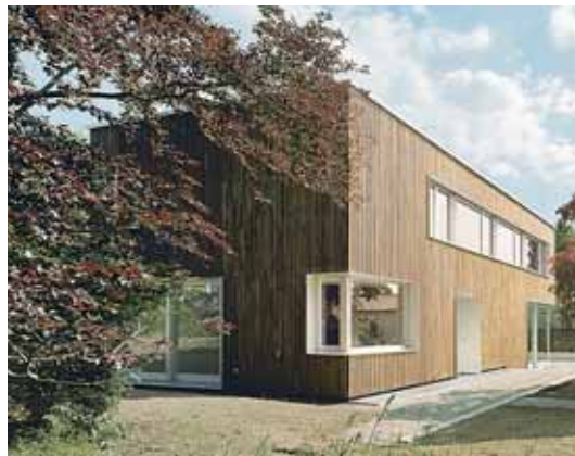
Figur 135: Thermobehandelte Lattung aus Edelkastanie Objekt: Maison Marron, Arlesheim (Dorenbach Architekten, Basel)
